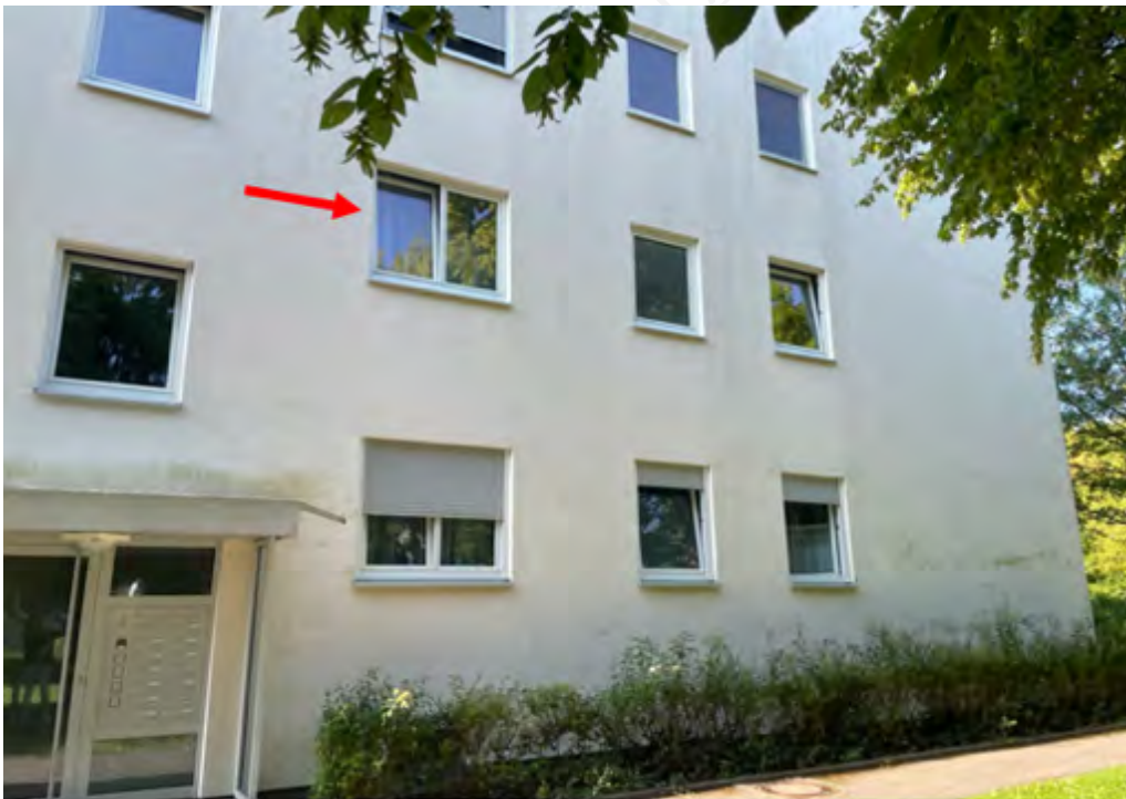
→ Norden mit Hauszugang
