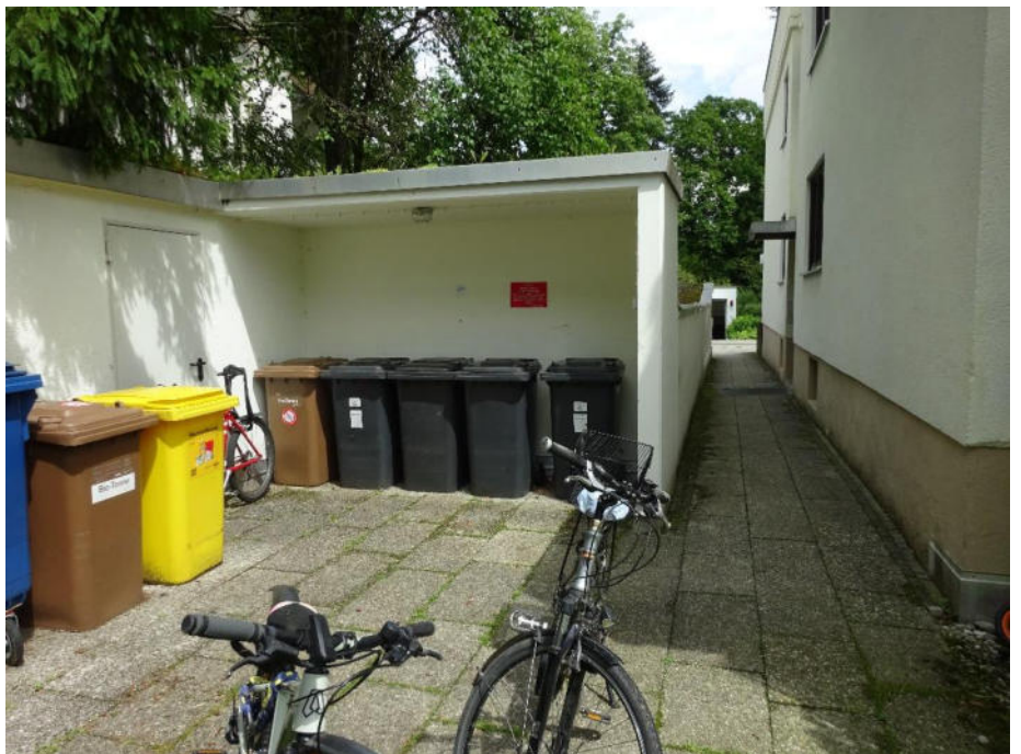
Nordseite mit Hauszugang, Einhausung Tiefgargenzufahrt und Mülltonnenstandplatz
