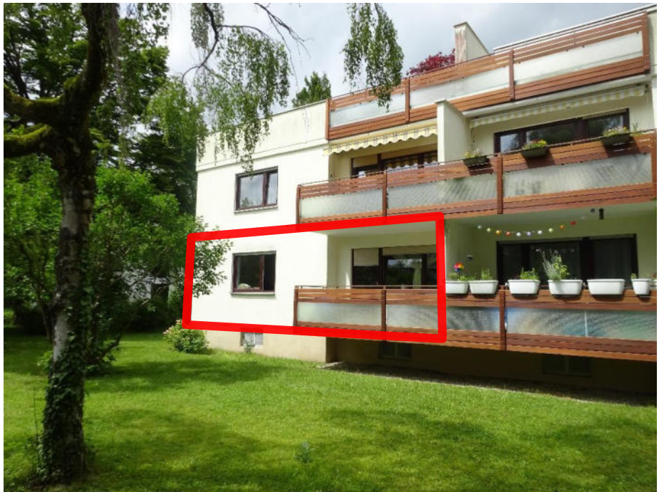
Südseite mit Kennzeichnung von Wohnung Nr. 5
