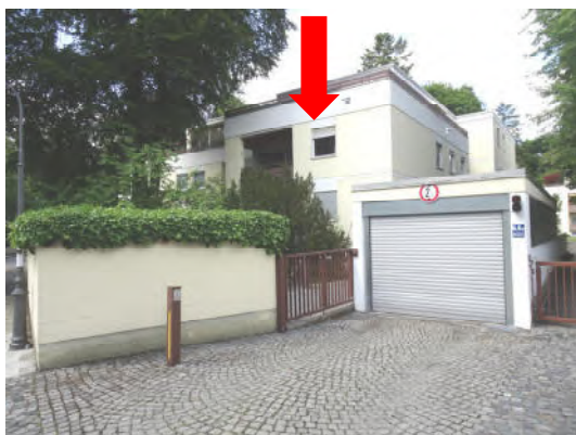
Südost- und Nordostseite des Gebäudes
