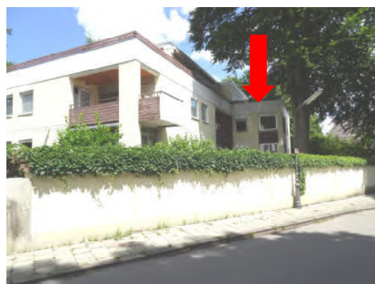
Südwest- und Südostseite des Gebäudes
