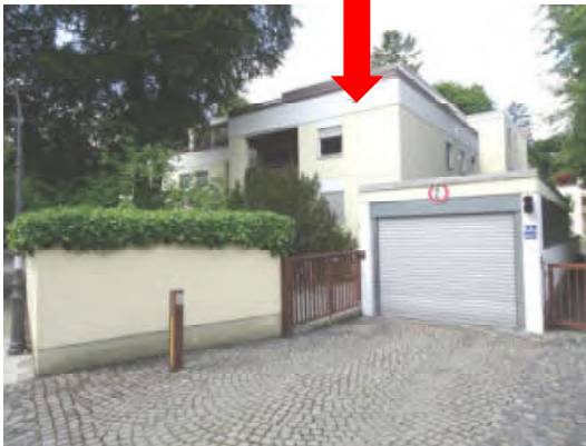
Südost- und Nordostseite des Gebäudes
