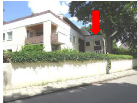
Südwest- und Südostseite des Gebäudes
