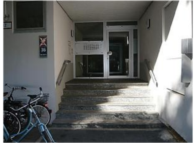
Hauseingang v. Nordosten
