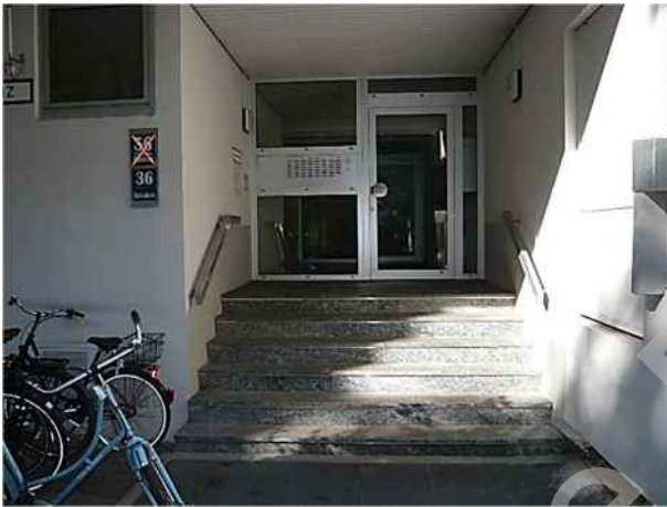
Hauseingang v. Nordosten
