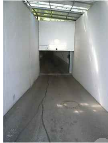
Ein-/Ausfahrt (Leonrodstraße) v. Nordwesten
