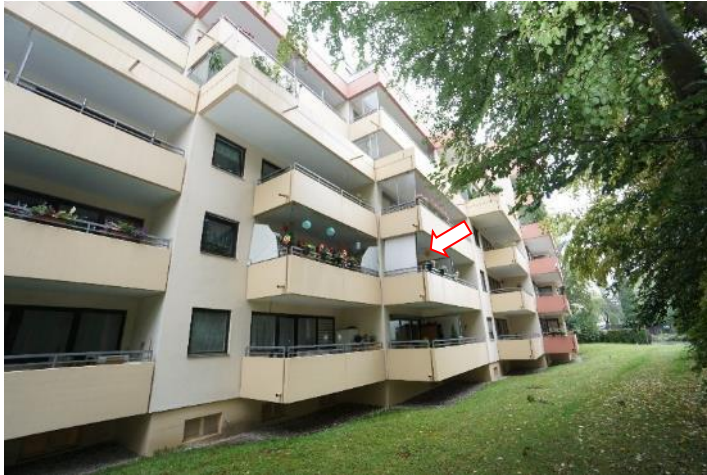
Der Pfeil deutet auf den Balkon der Sondereigentumseinheit Nr. 25.
