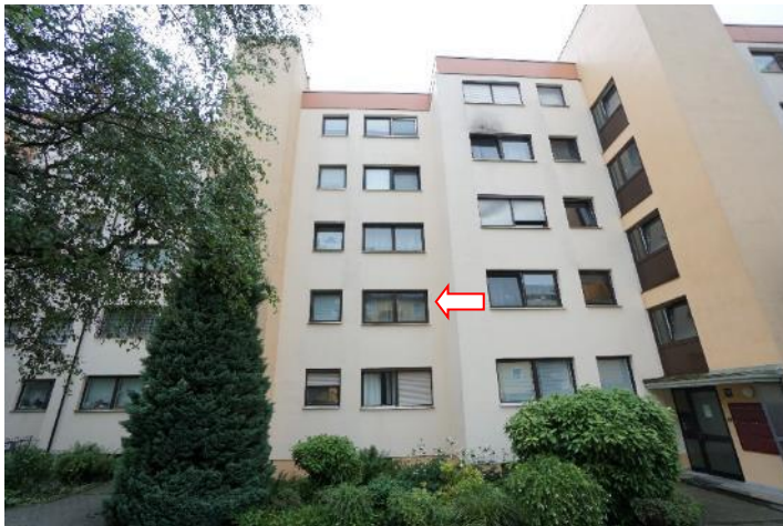
Ansicht aus Richtung Nordwesten. Der Pfeil deutet auf das Schlafzimmerfenster der Sondereigentumseinheit Nr. 25. Links daneben liegt das Küchenfenster.
