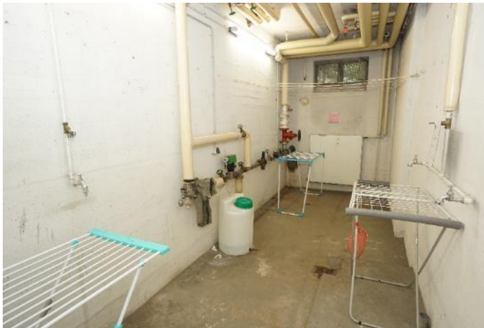
Trockenraum im Keller
