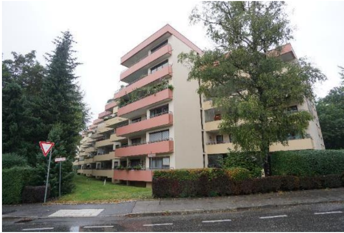
Gebäudeansicht von der Holzhofstraße in westliche Richtung
