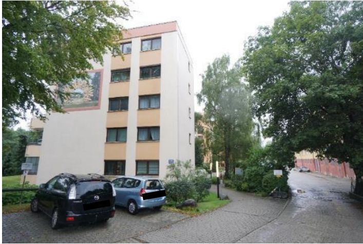
Zufahrt zu den Stellplätzen im Hof
