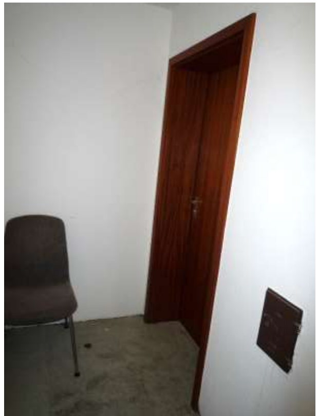
Zugang Keller Nr. 6
