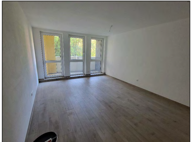
Blick in das Wohnzimmer in Richtung Innenhof; die ETW wurde komplett renoviert; Boden in der ganzen Wohnung mit Feinsteinzeugfliesen im Dielenformat mit Holzoptik
