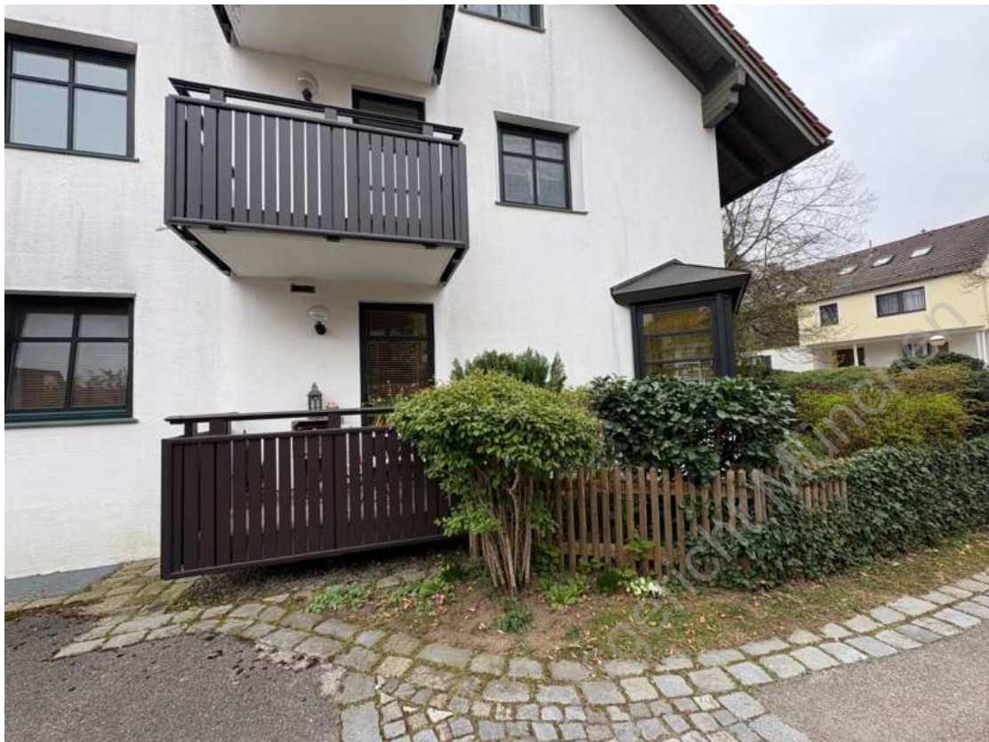
Foto 5: Nordwestfassade, Balkon Wohnung Nr. 18
