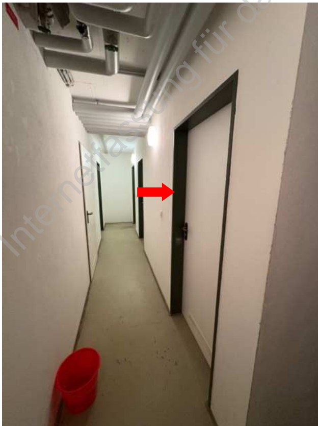
Foto 21: Zugang Keller Nr. 18
