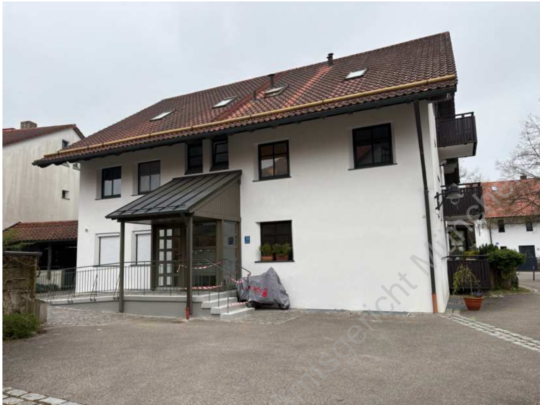
Foto 3: Nordostfassade mit Hauseingang
