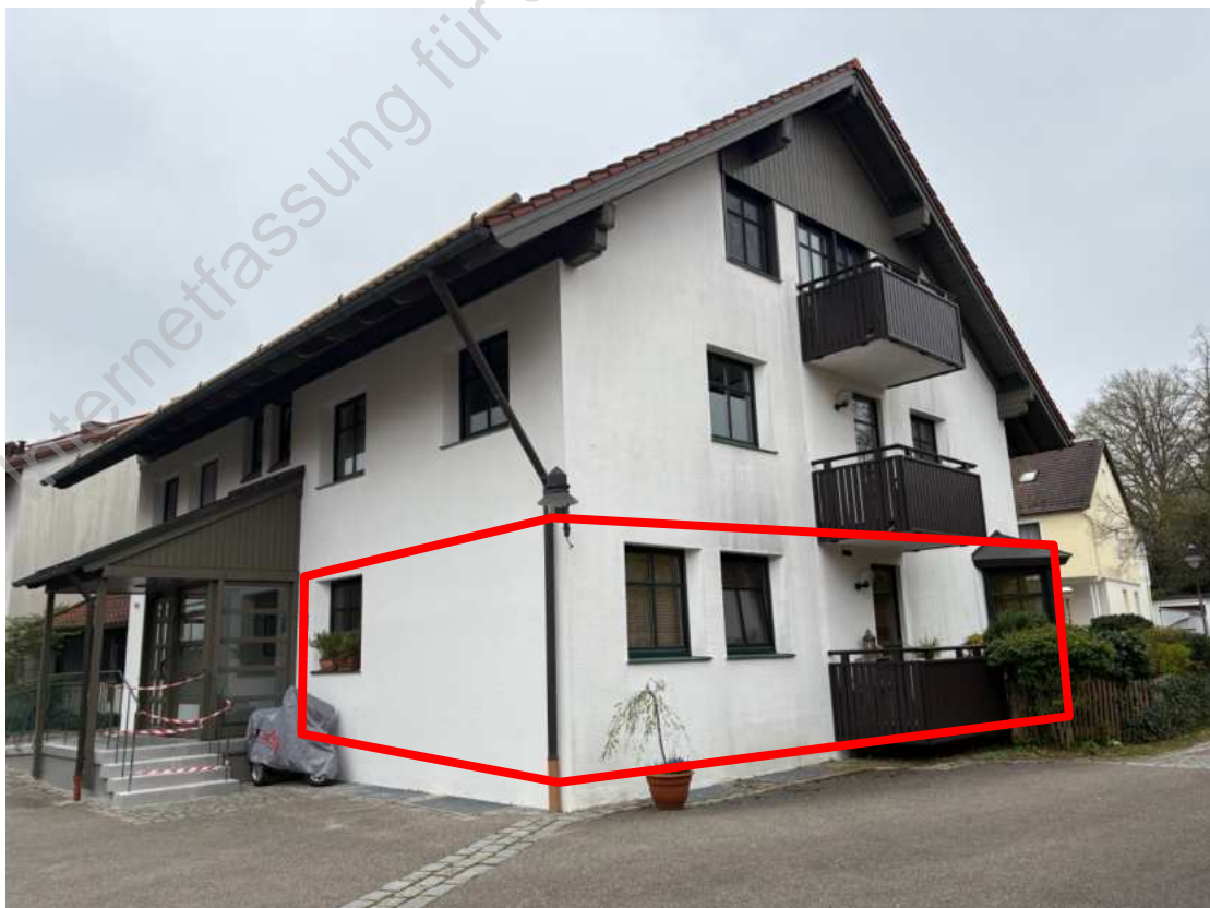
Foto 2: Blick von Norden mit Hauseingang
