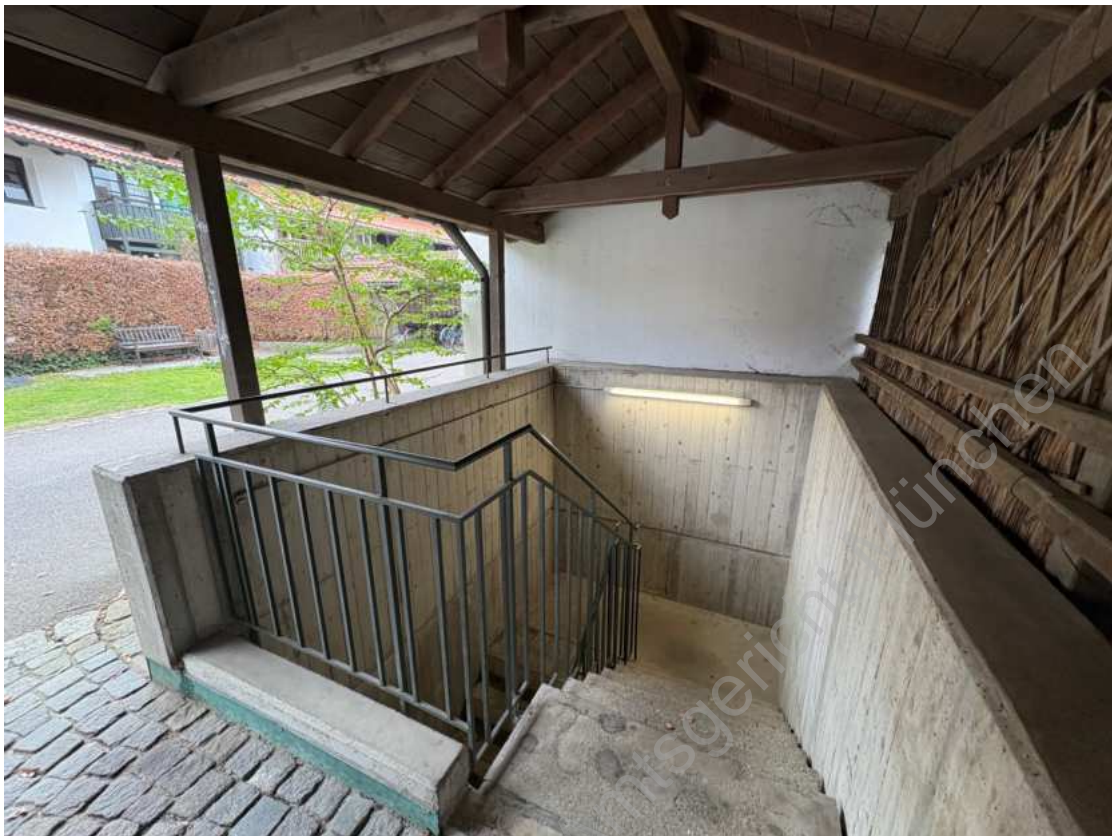
Foto 12: Zugang zur Tiefgarage
