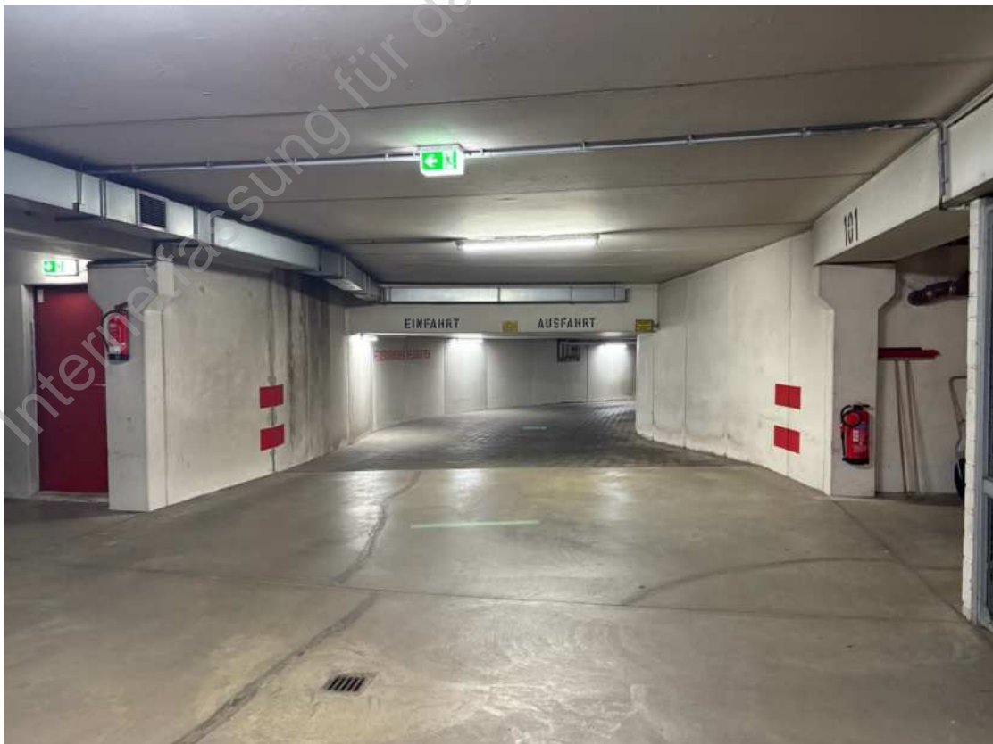
Foto 24: Tiefgaragenein- und ausfahrt
