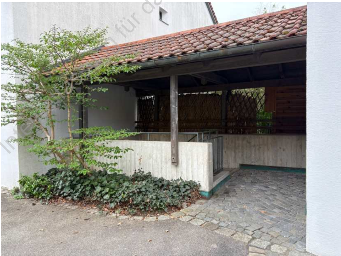
Foto 13: Zugang zur Tiefgarage
