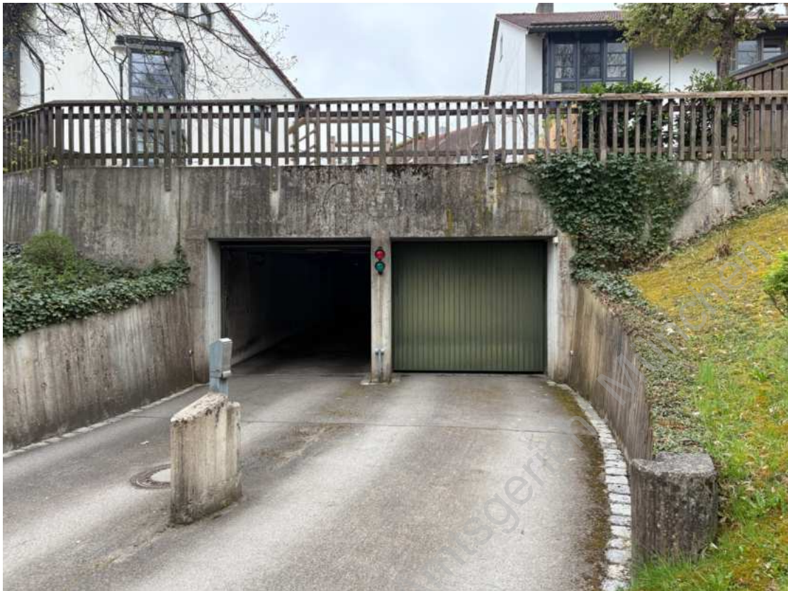
Foto 23: Tiefgaragenein- und ausfahrt
