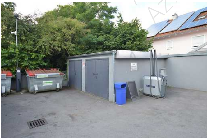
2 Einzelgaragen in der Südwestecke
