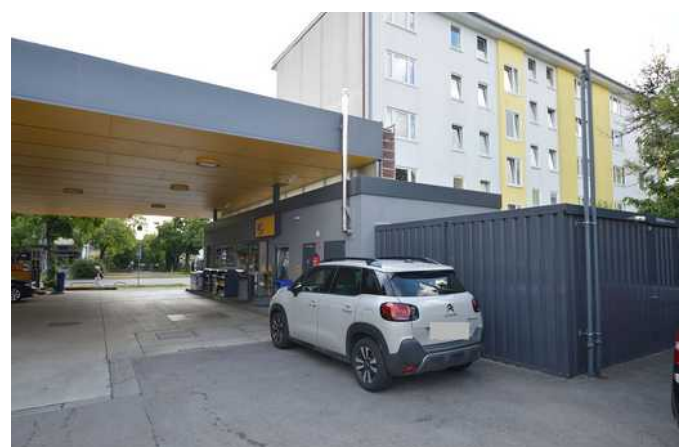
Ansicht von Westen mit Grenzbebauung
