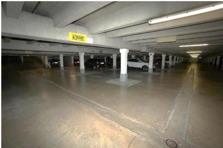
Tiefgarage – Gut erkennbar ist, dass bereits eine kostenintensive Betonsanierung der Stützen erfolgt ist.
