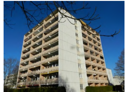
Ansicht auf Süd- und Ostfassade
