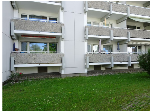
Ansicht von Südwesten, Loggia im EG
