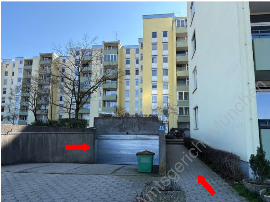
Foto 3: Zugang zum Hauseingang, Ein- und Ausfahrt Tiefgarage
