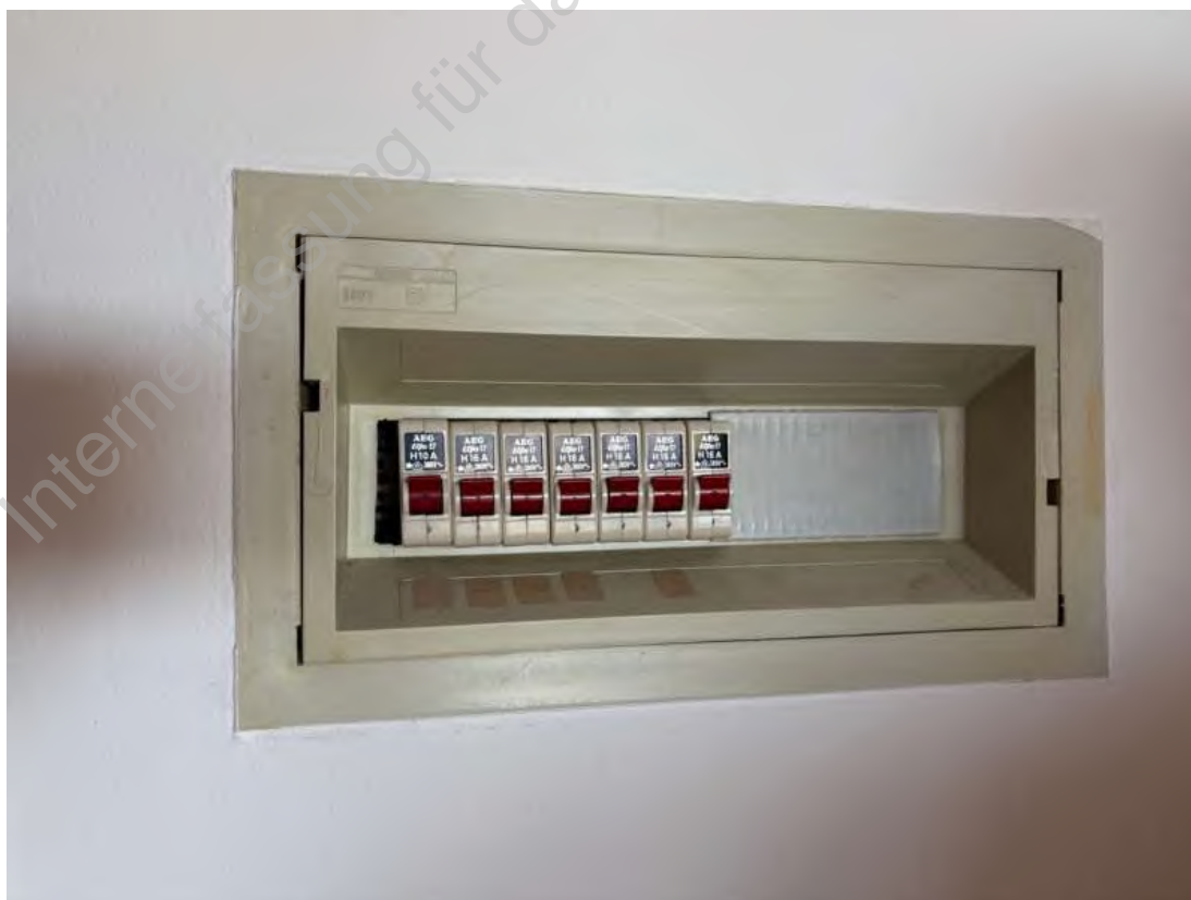
Foto 25: Elektro-Unterverteiler
