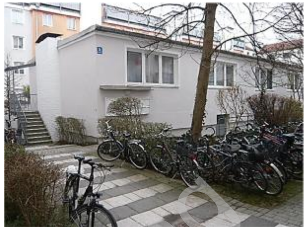
Rückgebäude v. Südosten
