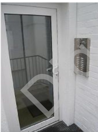
Hauseingang v. Süden
