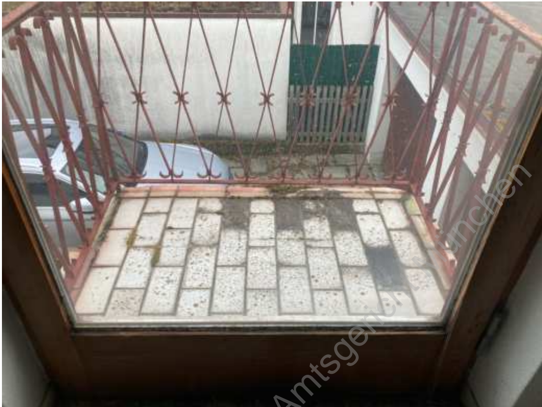
Foto 48: Balkon über Hauseingang
