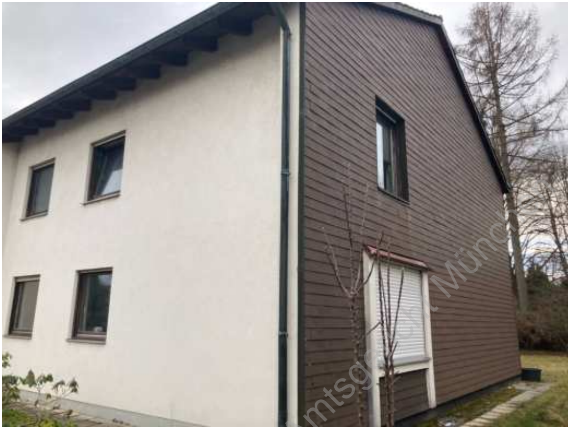
Foto 8: Westgiebel mit Fassadenplatten
