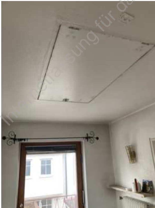
Foto 49: Zugang zum Speicher
