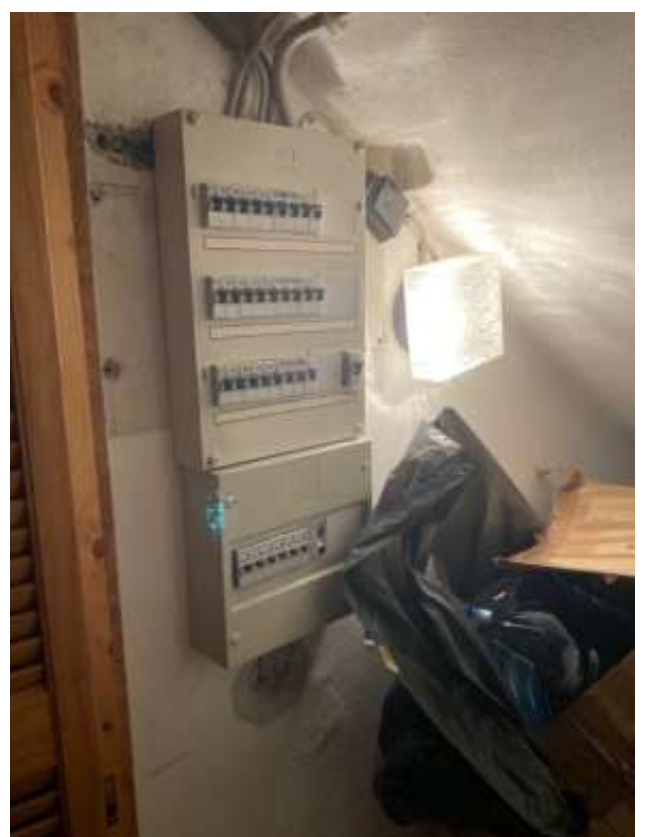
Foto 74: Elektro-Unterverteilung
