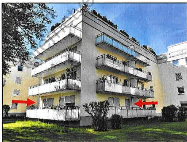
Die gegenständliche ETW liegt an der Nordostecke des Gebäudes mit zwei Balkonen (siehe Pfeile)
