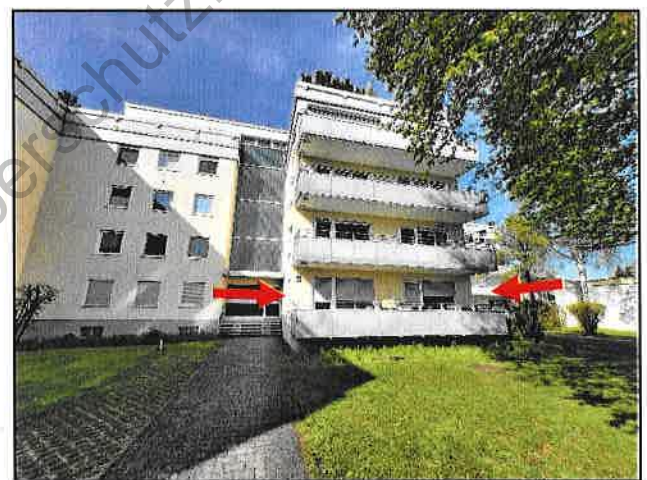
Vorderansicht des Gebäudes
