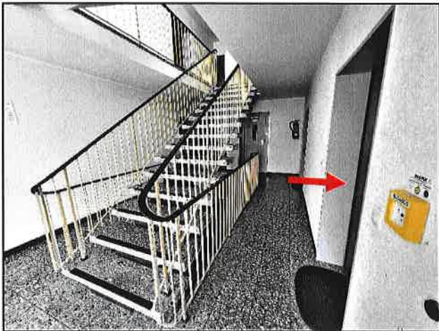
Blick vom Hauseingang Richtung Treppenhaus; ETW Nr. 201/20 rechts (siehe Pfeil)
