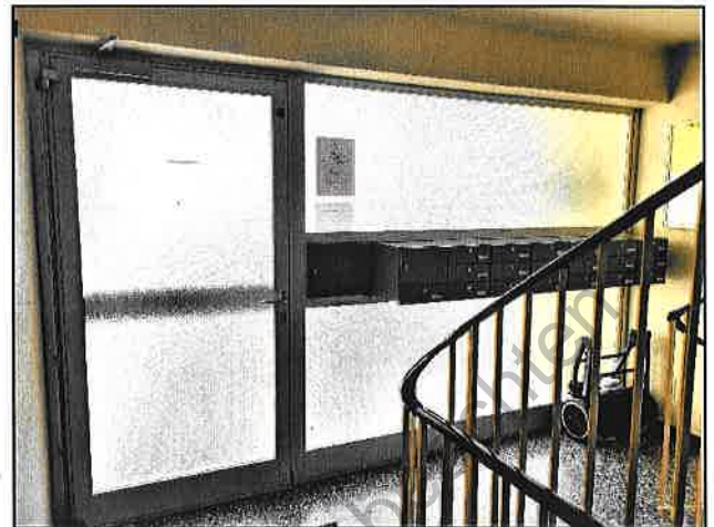
Blick auf die Eingangstür mit integrierter Briefkastenanlage
