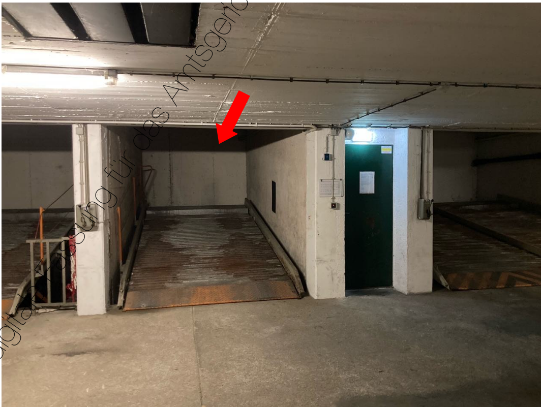
Foto 15: Duplexparker Nr. 9/10 neben dem Zugang zum Treppenhaus
