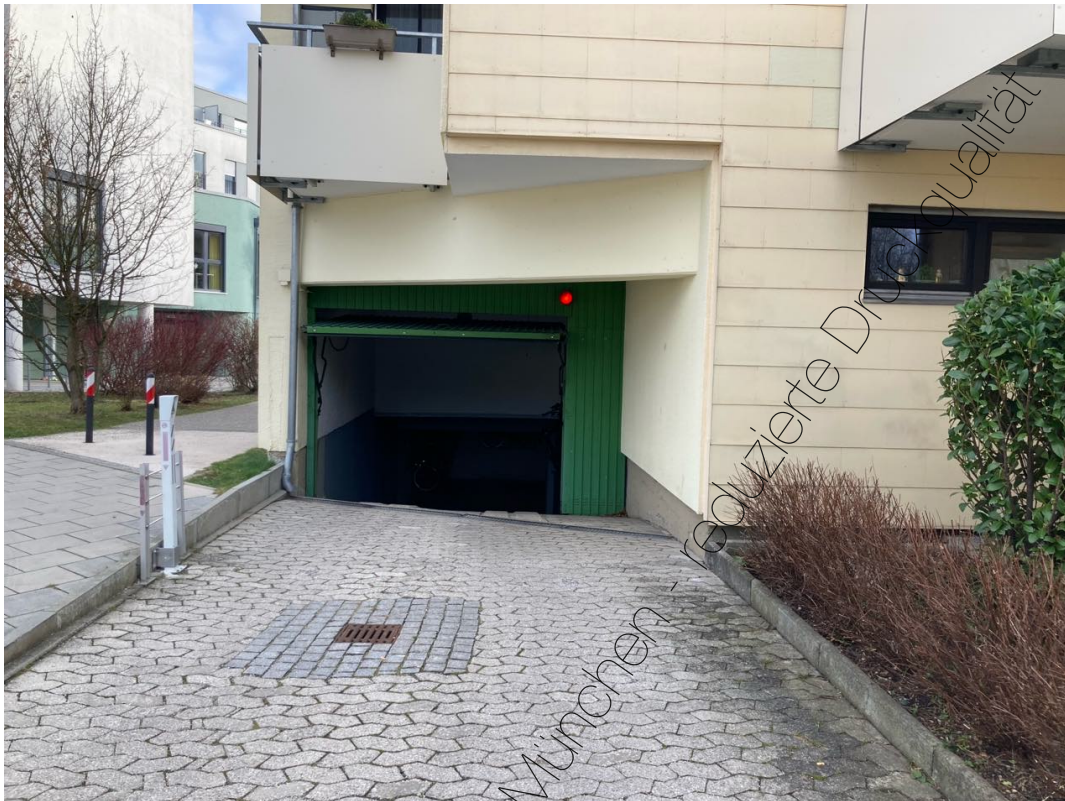
Foto 4: Tiefgaragenein- und ausfahrt
