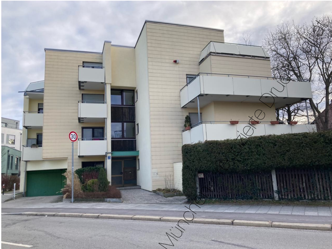
Foto 1: Blick von der Baubergerstraße
