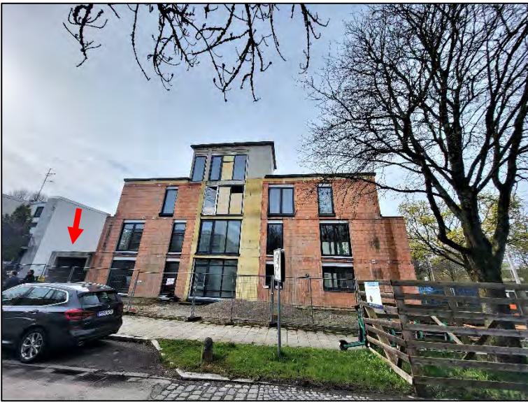
Blick von der Meistersingerstraße auf das Mehrfamilienhaus im Rohbau, die Tiefgaragenzufahrt befindet sich an der Ostseite (siehe Pfeil)
