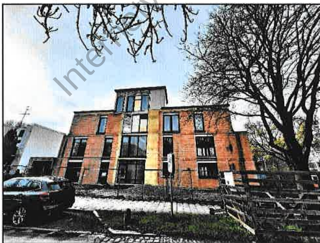
Vorderansicht des Gebäudes
