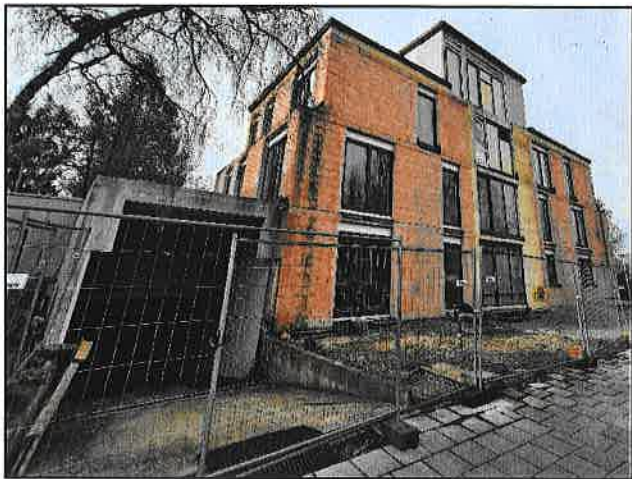
Ost- und Nordseite des Gebäudes; Tiefgaragenzufahrt an der Ostseite des Gebäudes
