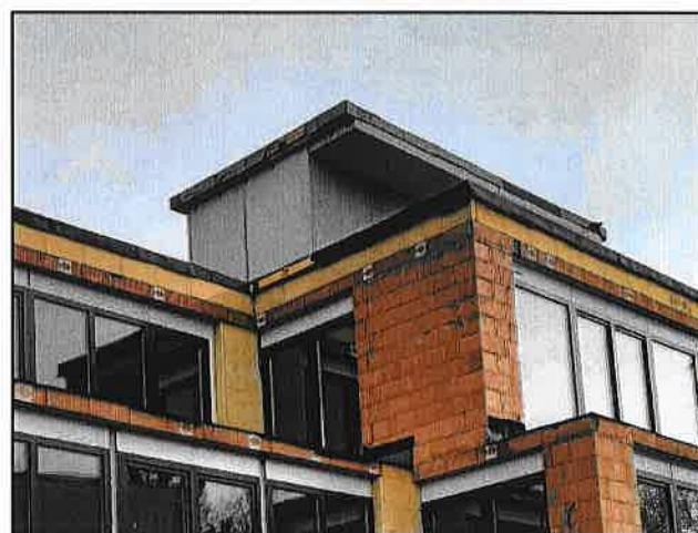
Nahansicht Dachgeschoss mit Dachaufbau für Aufzugsschacht
