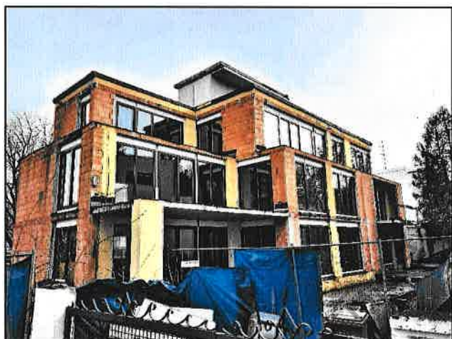
Rückwärtige Nahansicht vom Bauzaun
