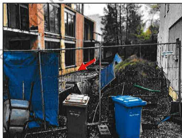
Südlicher Grundstücksbereich; relativ kurzer Abstand zum Nachbargebäude an der Cosimastraße
