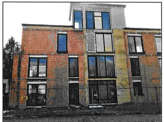
Nahansicht Vorderfront des Mehrfamilienhauses mit dem Hauseingang in der Mitte
