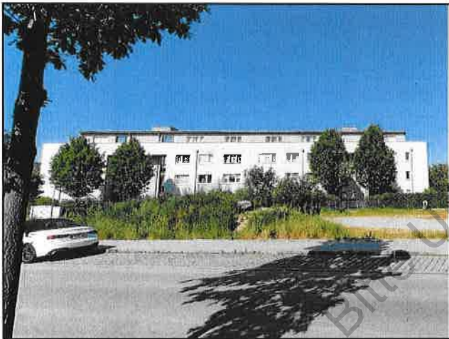
Nahansicht der größeren Eigentumswohnanlage westlich des Bewertungsgrundstücks
