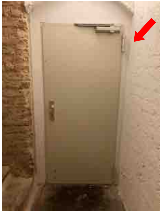
Foto 10: Eingang zu den Lagerräumen Nr. 15
