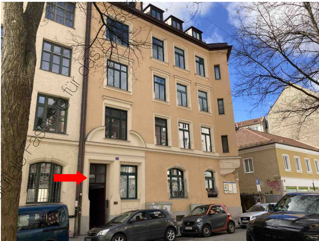
Foto 2: Blick von Nordosten zum Haupteingang
