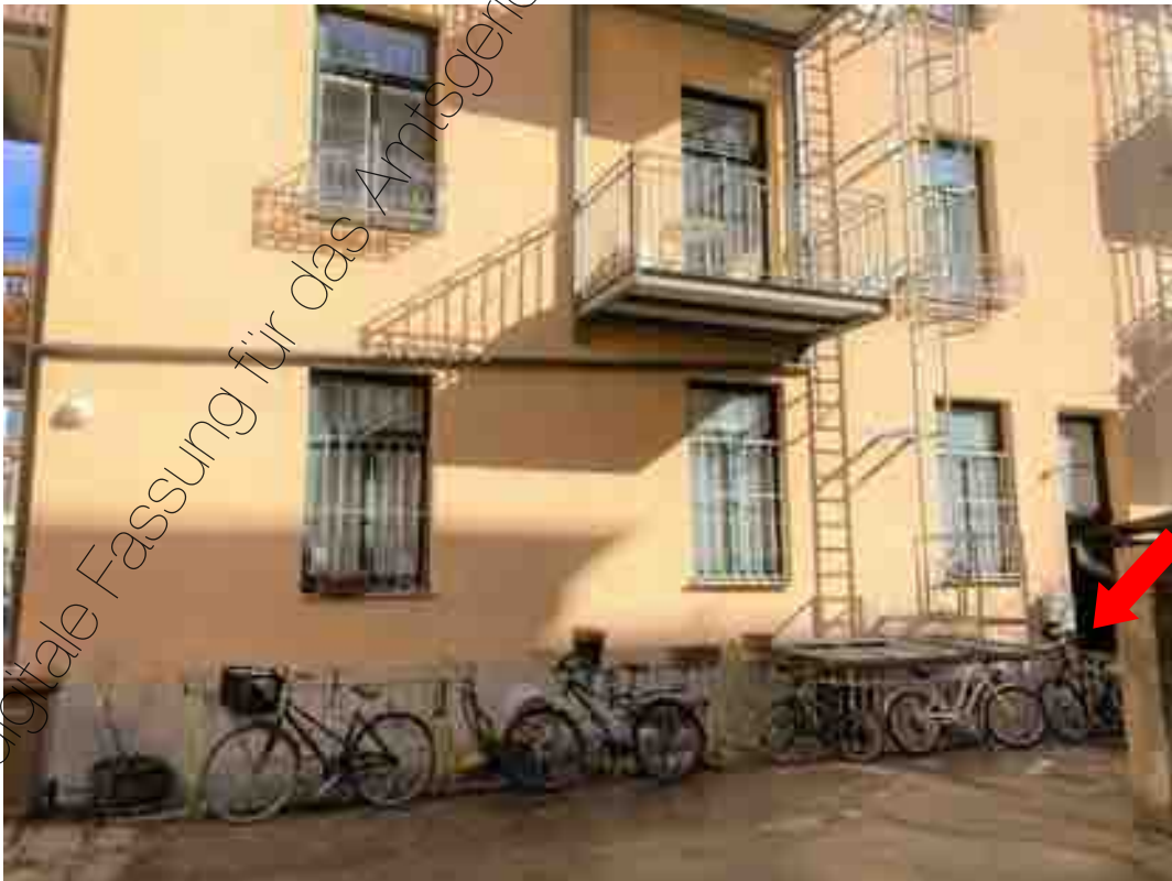
Foto 12: Außenzugang zum Lager Nr. 15
