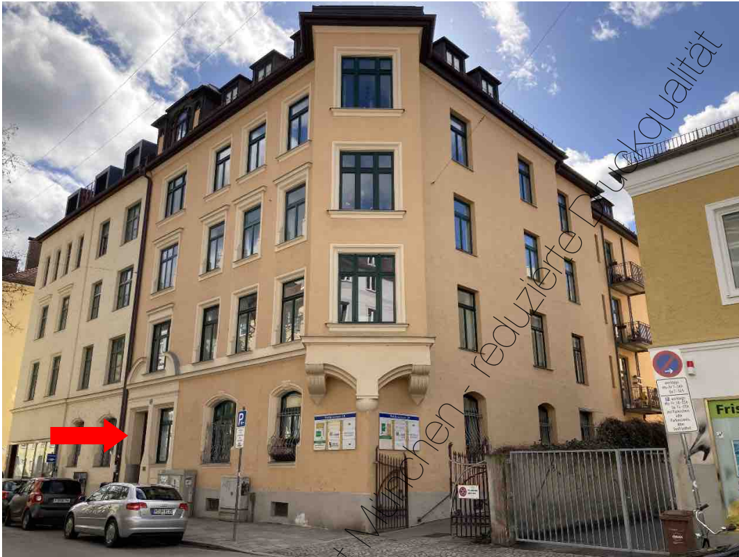
Foto 1: Straßenansicht, Zugang über das Vordergebäude
