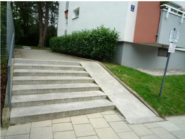
Zugang von Straße aus
