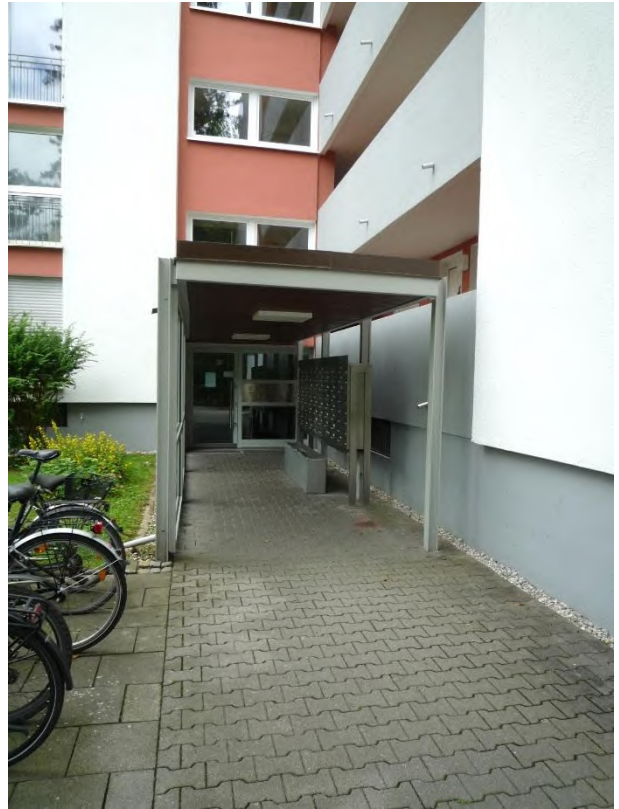
Eingang von Norden
