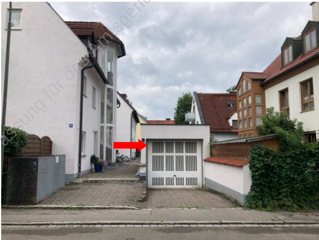
Foto 10: Ein- und Ausfahrt Tiefgarage
