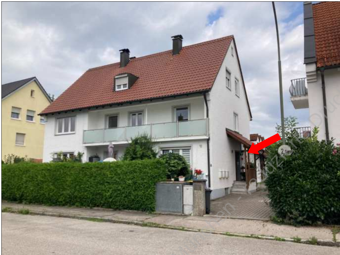
Foto 1: Blick von der Kleiststraße - Zugang zum Haus Nr. 10
