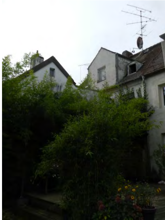
Ostfassade, Ansicht von Nordost
