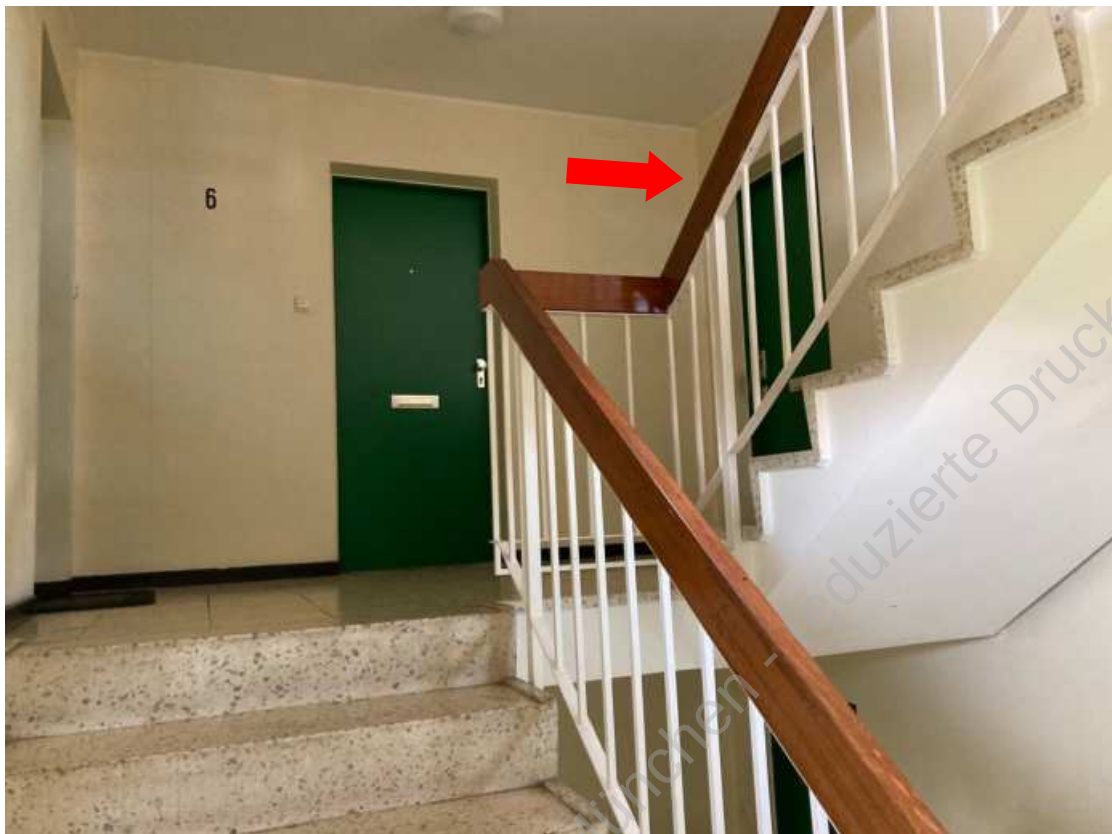
Foto 14: Aufgang zum 6. Obergeschoss
