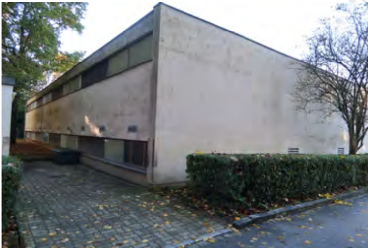
• Parkhaus auf Flurstück Nr. 569/2 Südwesten/Südosten
