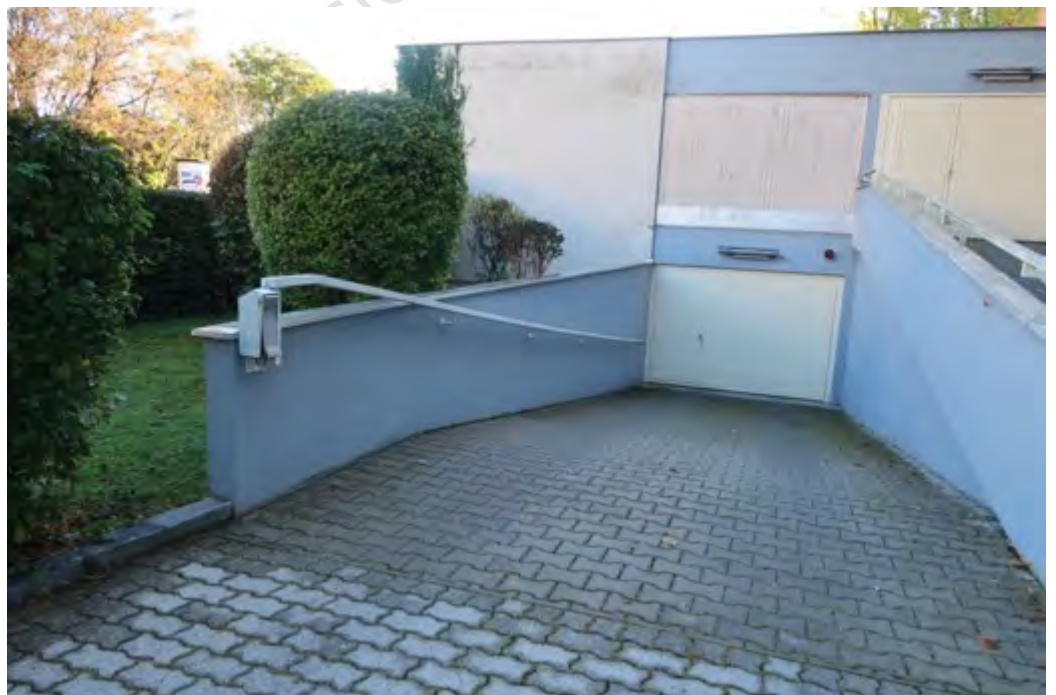
Stellplatz Nr. 219 befindet sich laut Planunterlagen im Unteren Deck
