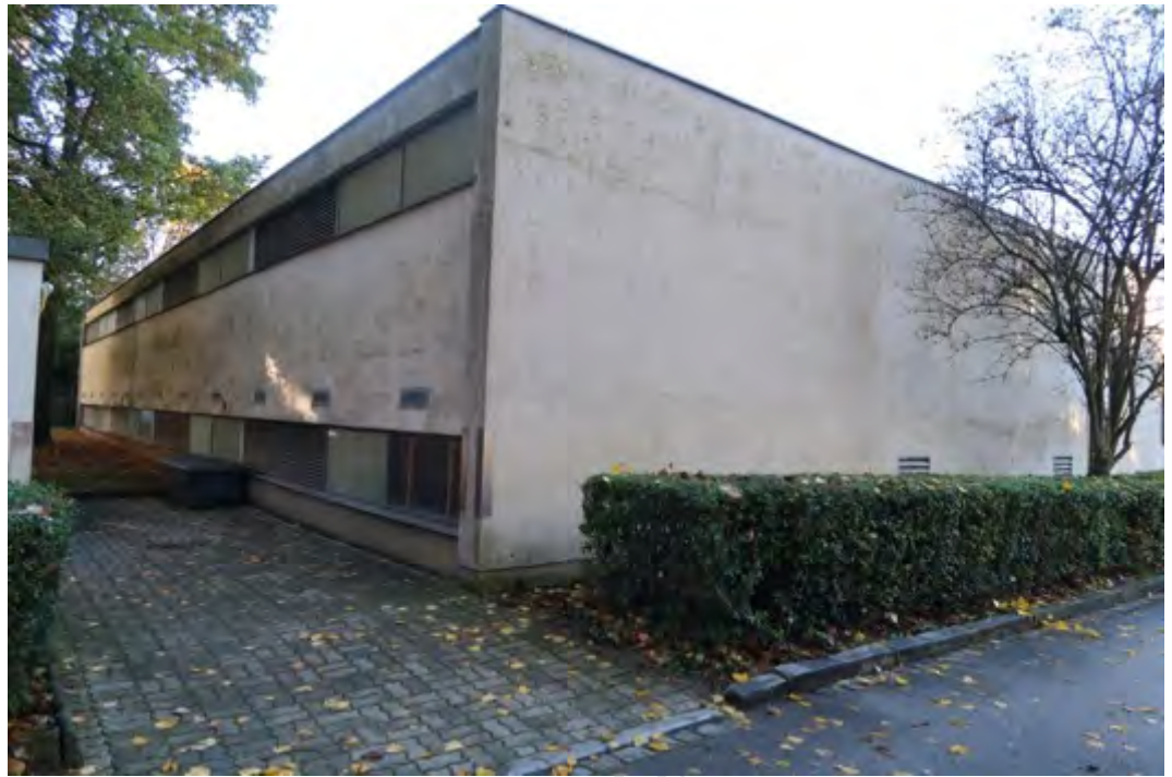
Parkhaus auf Flurstück Nr. 569/2 Südwesten/Südosten
