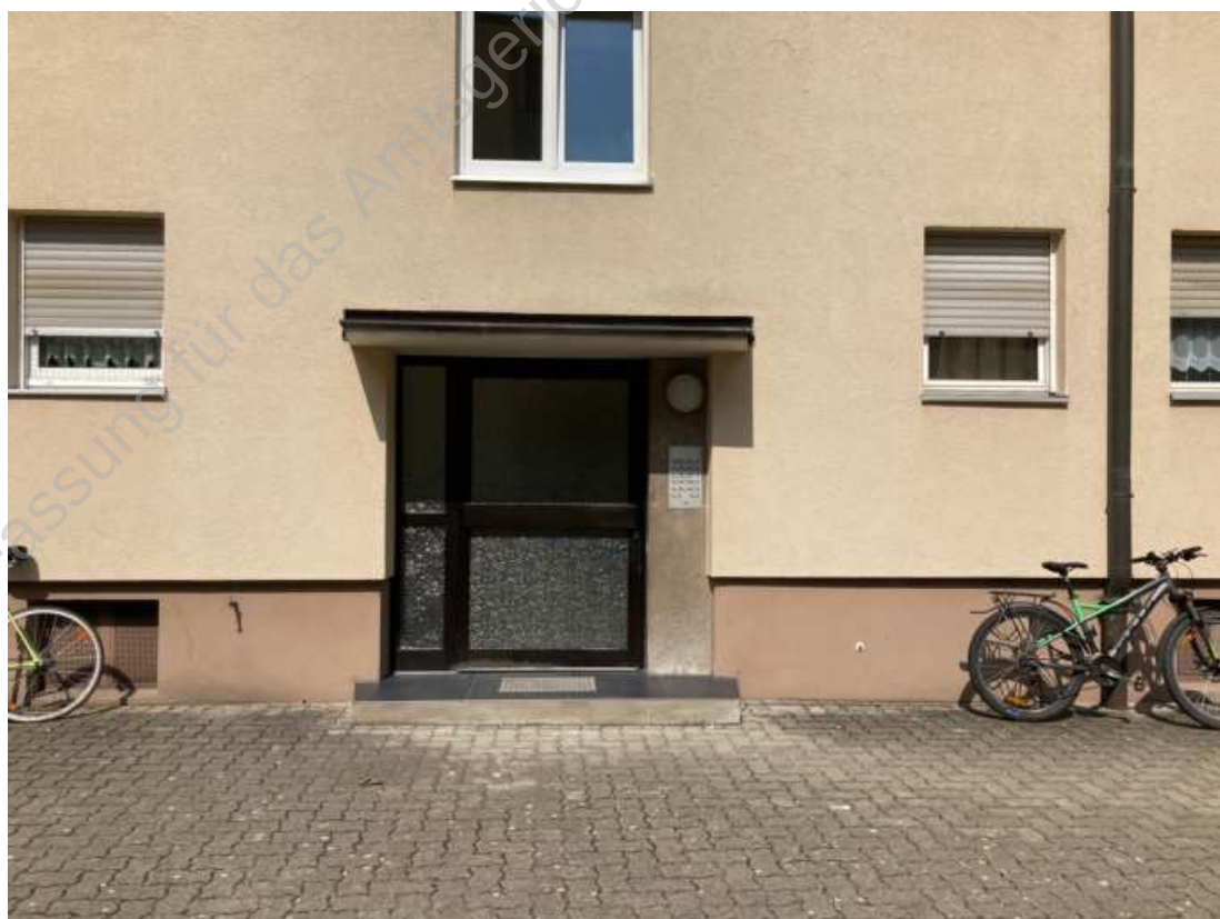
Foto 8: Hauseingang an der Ostseite
