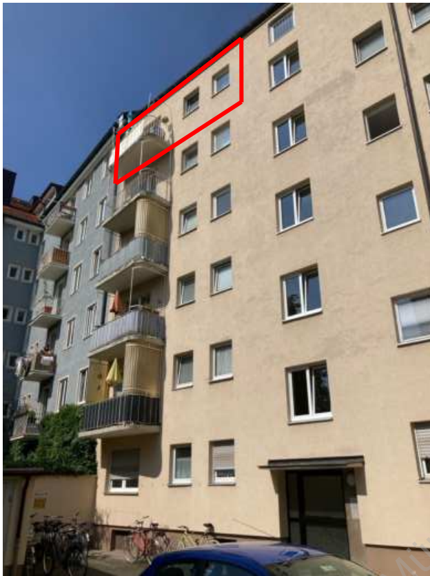
Foto 9: Ostfassade mit Wohnung Nr. 15
