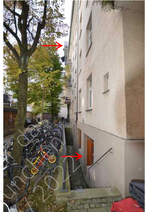
Außenabgang auf der Nordseite (mit Zugang zum Keller Nr. 46)
