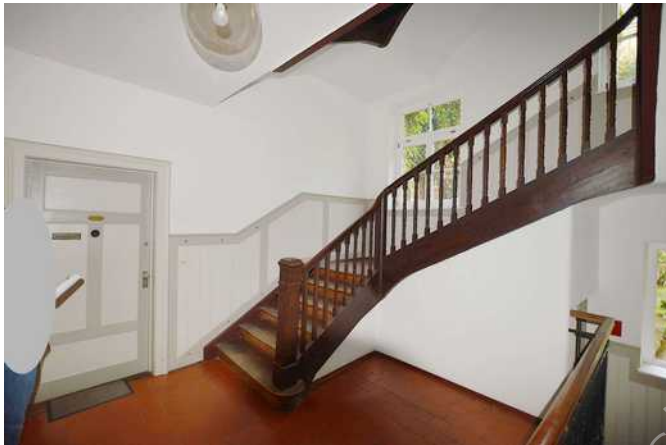
Treppenhaus im EG
