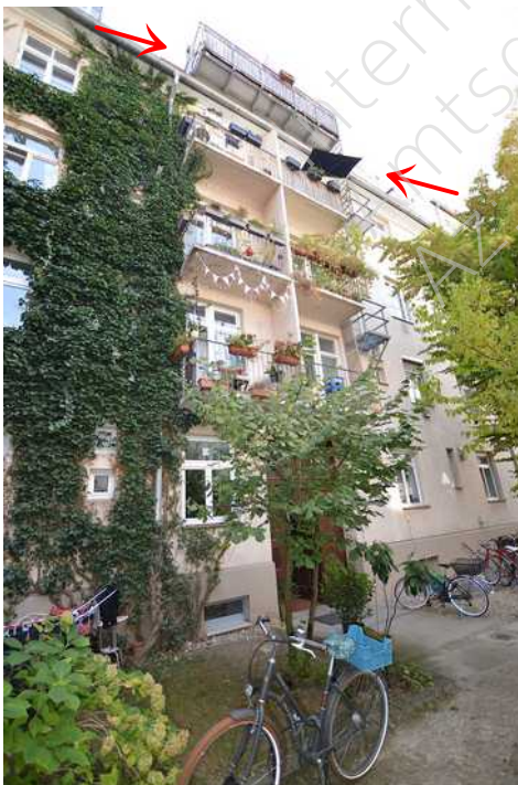
Rückgebäude Nordseite mit Durchgang
