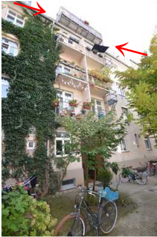
Rückgebäude Nordseite mit Durchgang
