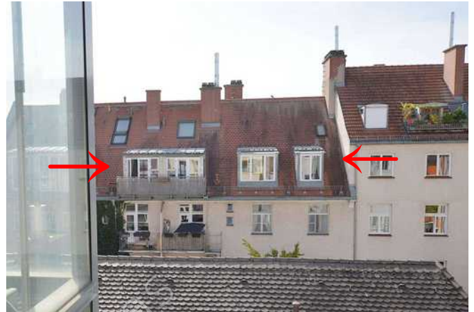
Rückgebäude, Dachansicht von Norden
