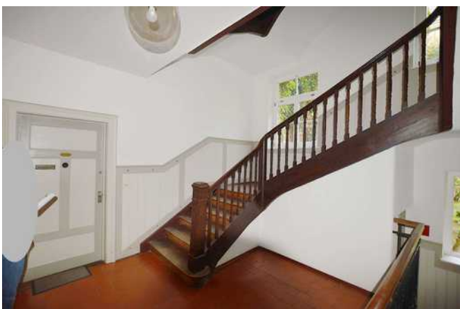
Treppenhaus im EG
