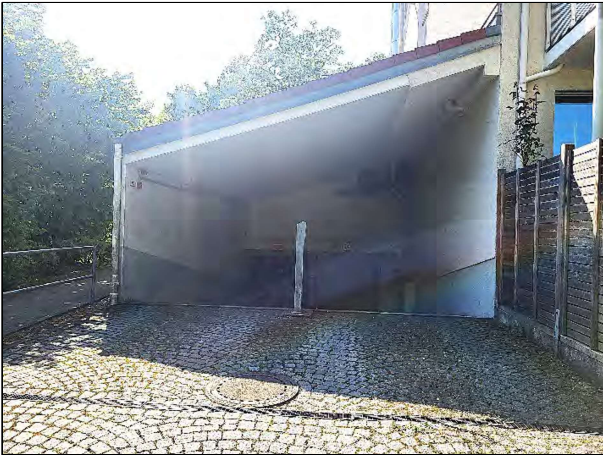
Die Zufahrt zur Tiefgarage befindet sich an der Nordostecke der Gebäudezeile
