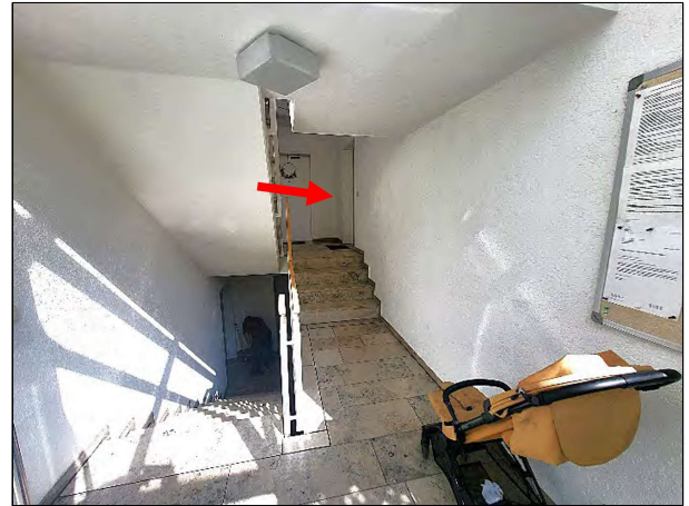
Blick vom Eingang Richtung Treppenhaus; Wohnungstür zur ETW Nr. 23 rechts
