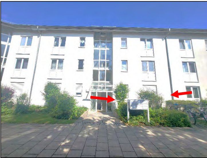
Vorderansicht des Gebäudes Mitterfeldring 6; die Eigentumswohnung Nr. 23 befindet sich im EG (siehe Pfeile)
