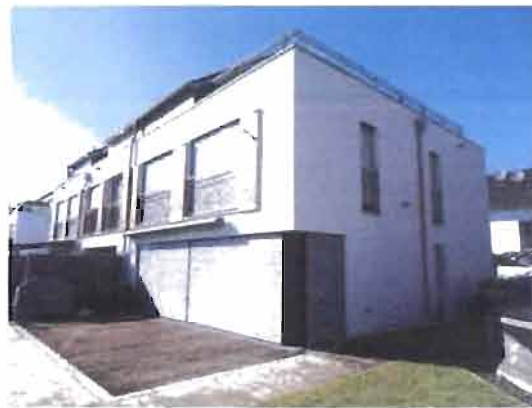
Süd- und Ostseite des Gebäudes
