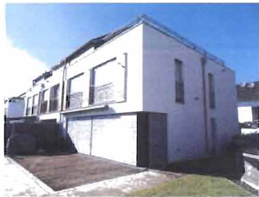
Süd- und Ostseite des Gebäudes
