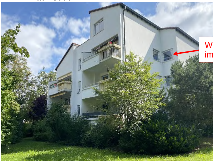
Bild 3 – Blick auf Wohnanlage Bilgeristr. 33 von Westen nach Süden
