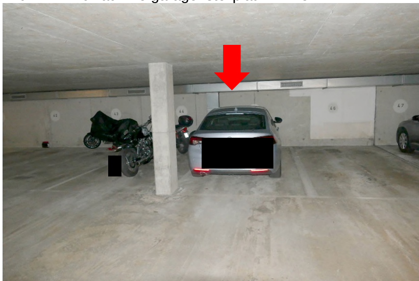
Bild 14 – Blick auf Tiefgaragenstellplatz Nr. 45
