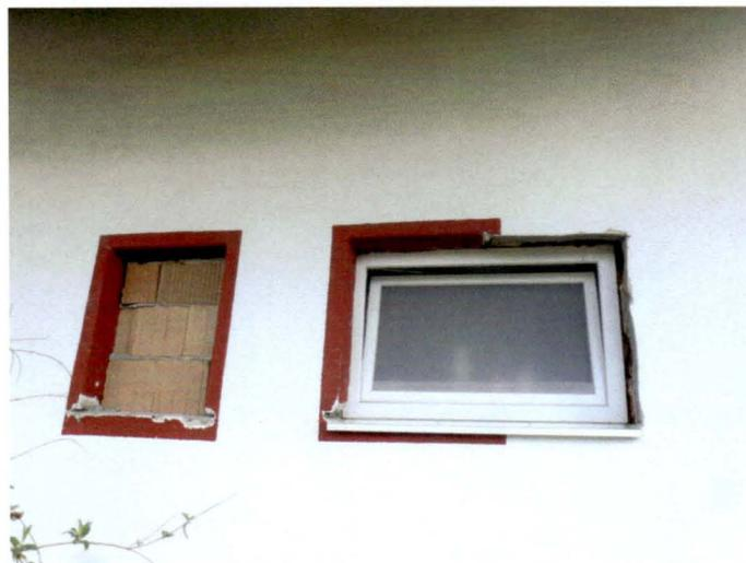
**fehlende Dämmung, fehlender Putz an der Westfassade**
