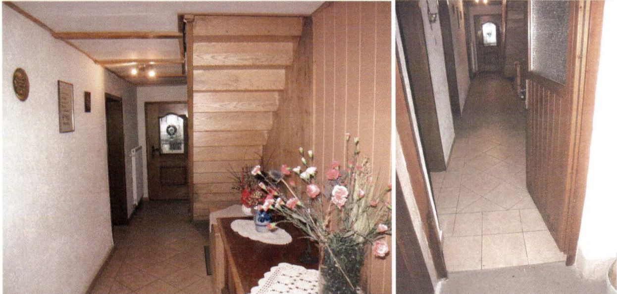
Eingangs-/Flurbereich Erdgeschoss mit Fliesenbelag, verputzten bzw. verkleideten Wänden und verkleideten Unterdecken einer Hohldecke;
