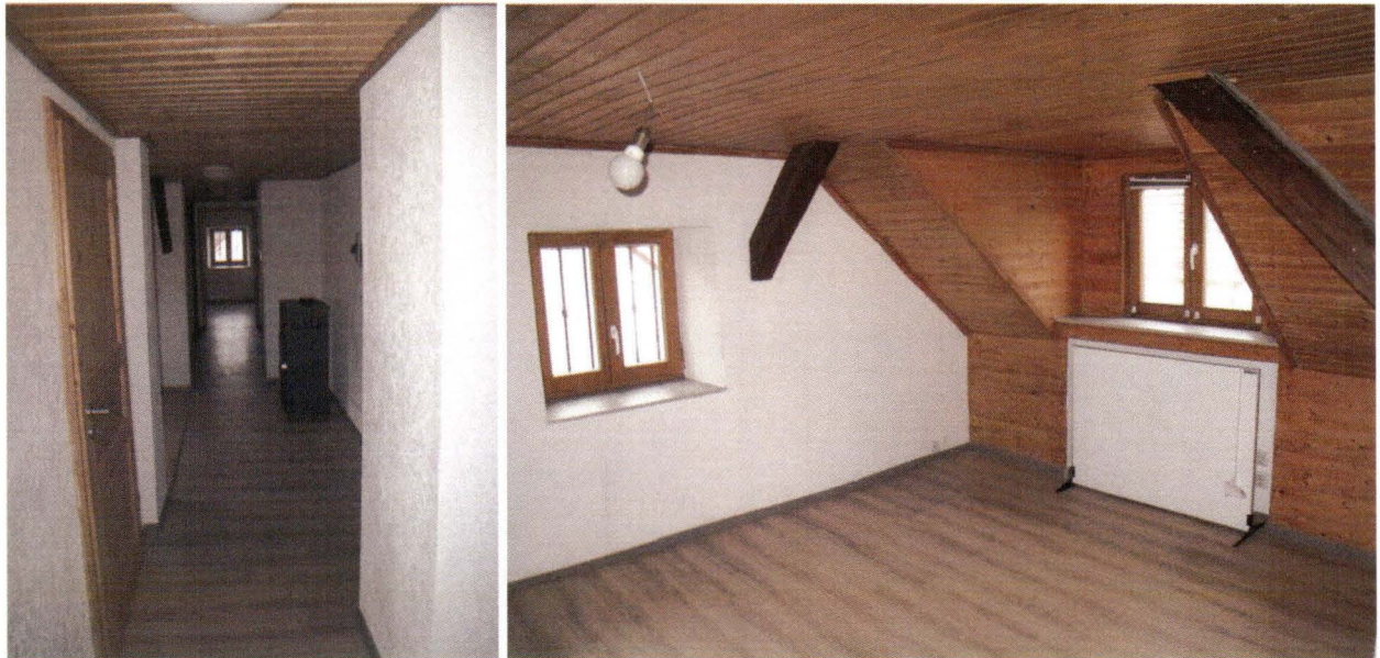
Nachträglicher Dachausbau mit Holzdecke, Linoleum-Böden und verputzten Wänden
