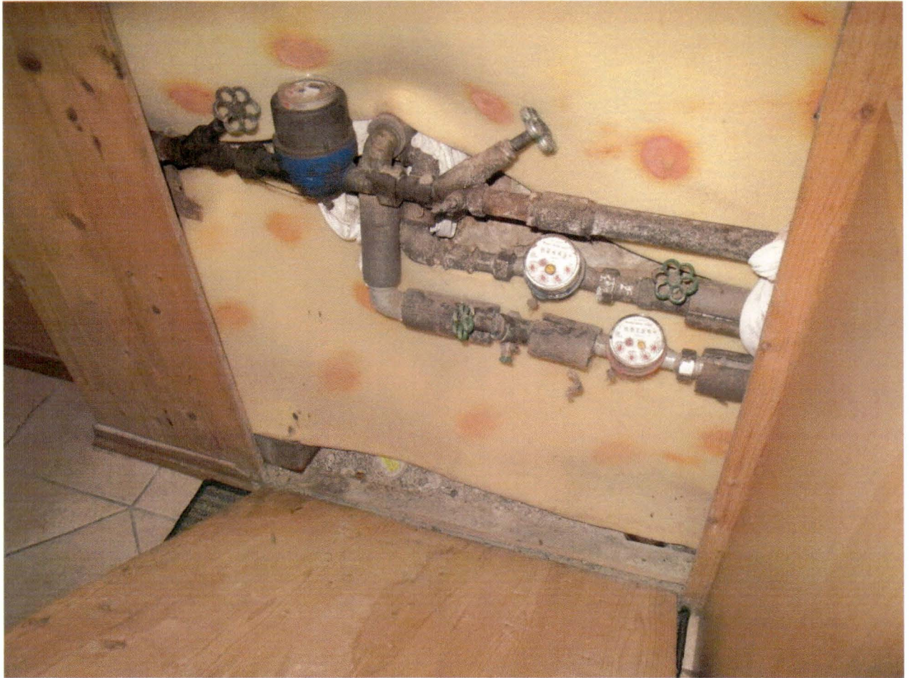
Wasser-Hausanschluss mit separaten Zählern für die OG- und die DG-Wohnung Strom-Hausanschluss über Dach mit Sicherungs-/Verteilerkasten im Erdgeschoss:
