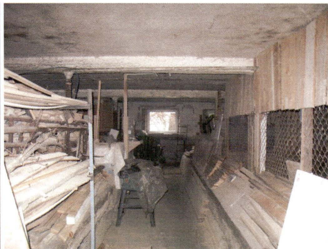
Gekalkter Stall; mit Eisenträger gestützte Massivdecke / Heuboden; Kaltlager (Holz) im Stall-Leerstand.
