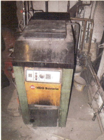
Holzvergaser mit Brauchwasser- und Pufferspeicher als Zentralheizung mit Radiatoren
