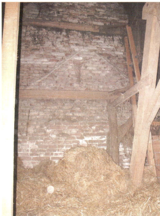
Gekalkter Stall; mit Eisenträger gestützte Massivdecke / Heuboden; Kaltlager (Holz) im Stall-Leerstand.
