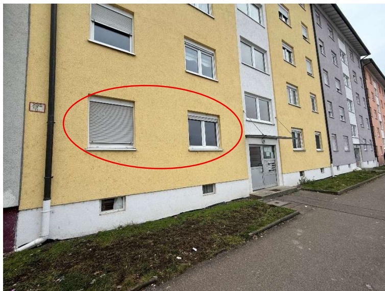
HsNr. 80, rot markiert: Fenster der Wohnung Nr. 1
