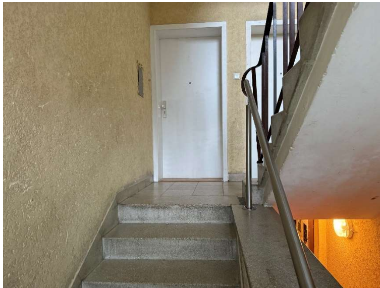
Hs.Nr. 80: Treppenhaus, rechts im Bild: Wohnungseingangstüre zu Whg. Nr. 1
