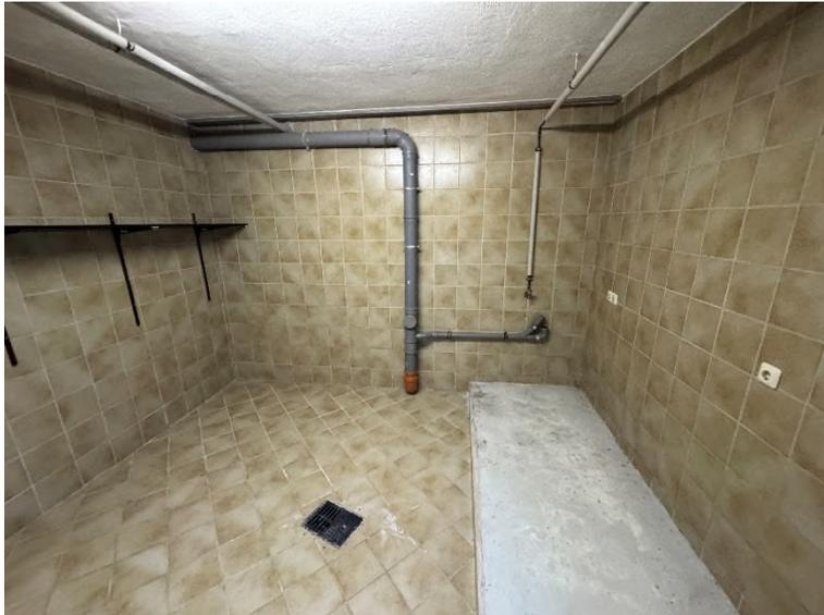
Bild 13 und Bild 14 – nicht fachgerecht verlegte Heizungsrohre im Keller
