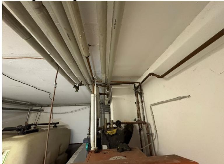
Bild 15 – nicht fachgerecht verlegte Abwasserleitung im Keller
