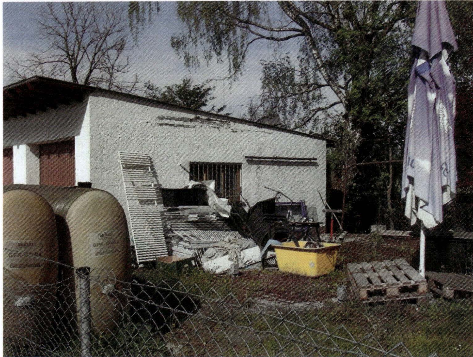
Blick nach -Südwesten-
