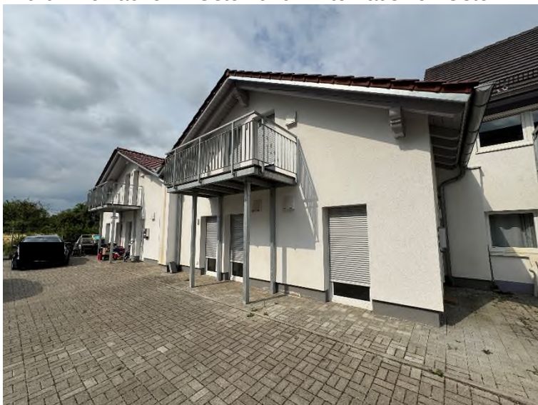
Bild 6 - Hoffläche im Osten und Hinterhaus von Osten
