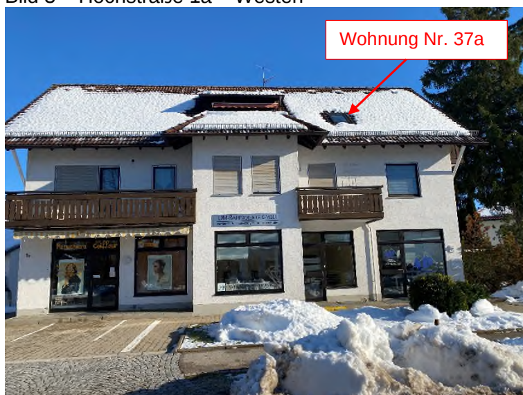
Bild 3 – Hochstraße 1a – Westen
