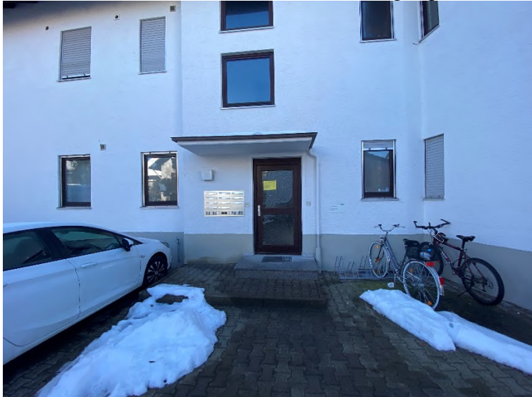
Bild 5 – Hochstraße 1a - Blick auf Hauseingang
