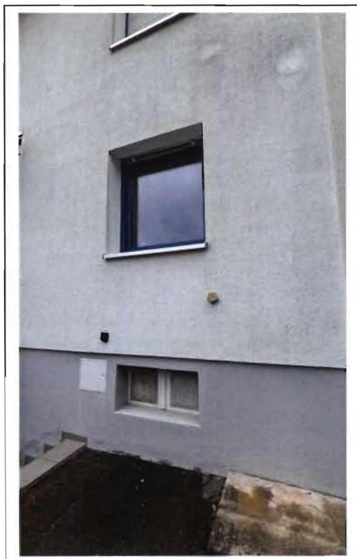
Foto 10: Wohnhausfassade mit WDVS
