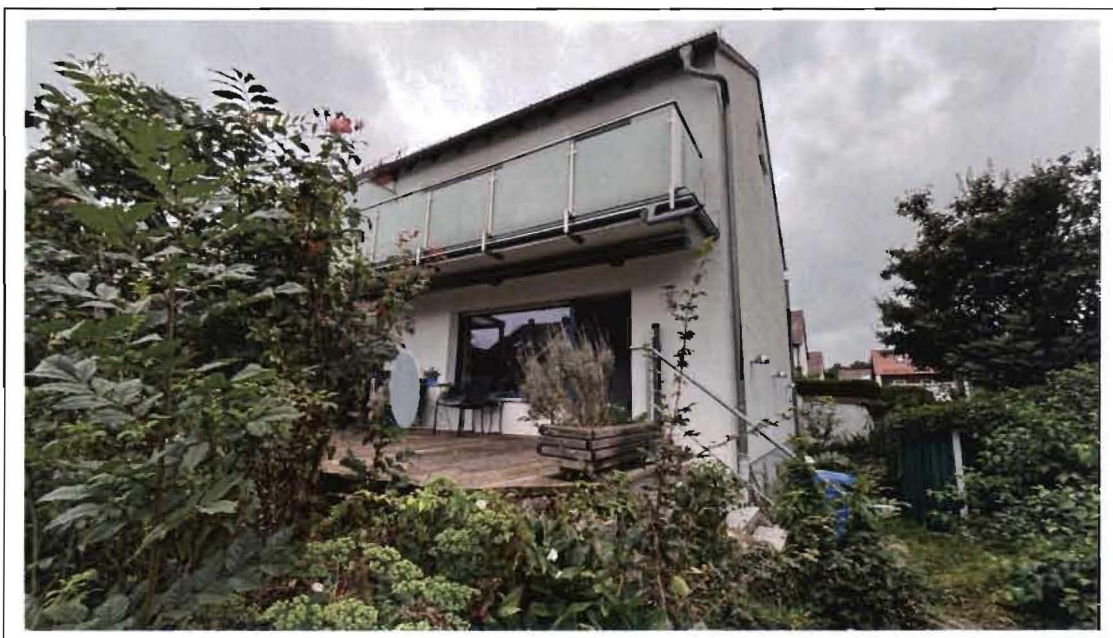
Foto 2: Ansicht von Südosten
