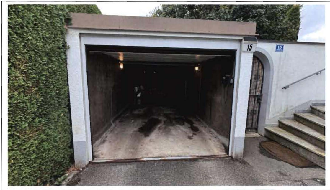
Foto 9: Garage - Ansicht von Westen
