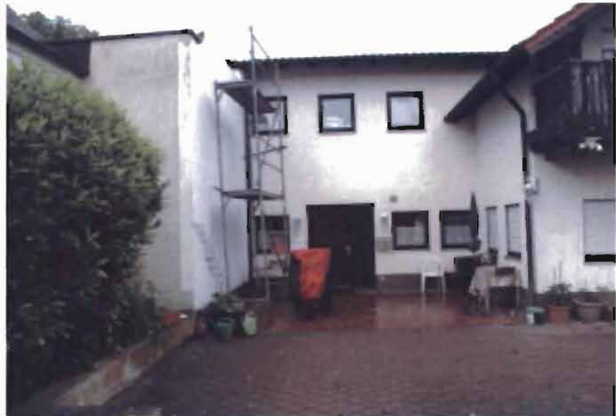
Bild 4: Haus 1 Ansicht Zwischenbau von Südwesten
