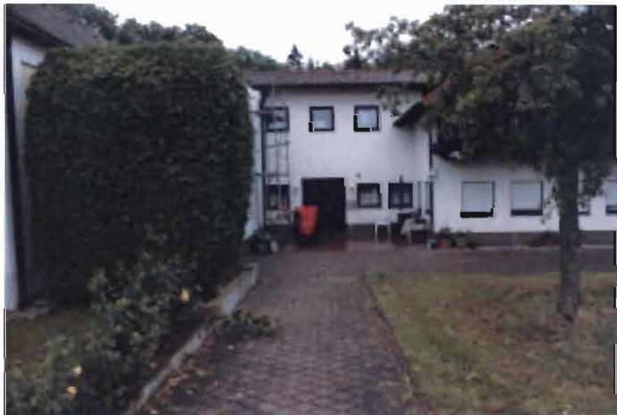
Bild 2: Haus 1 Ansicht Zwischenbau von Südwesten
