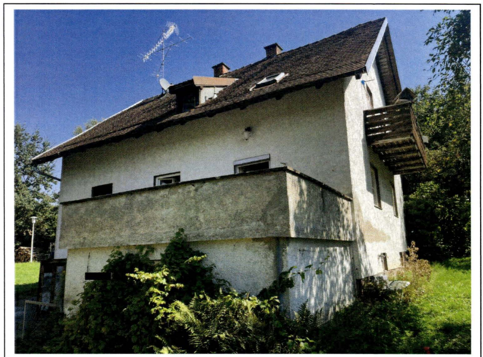
Foto 2: Ansicht von Südwesten
