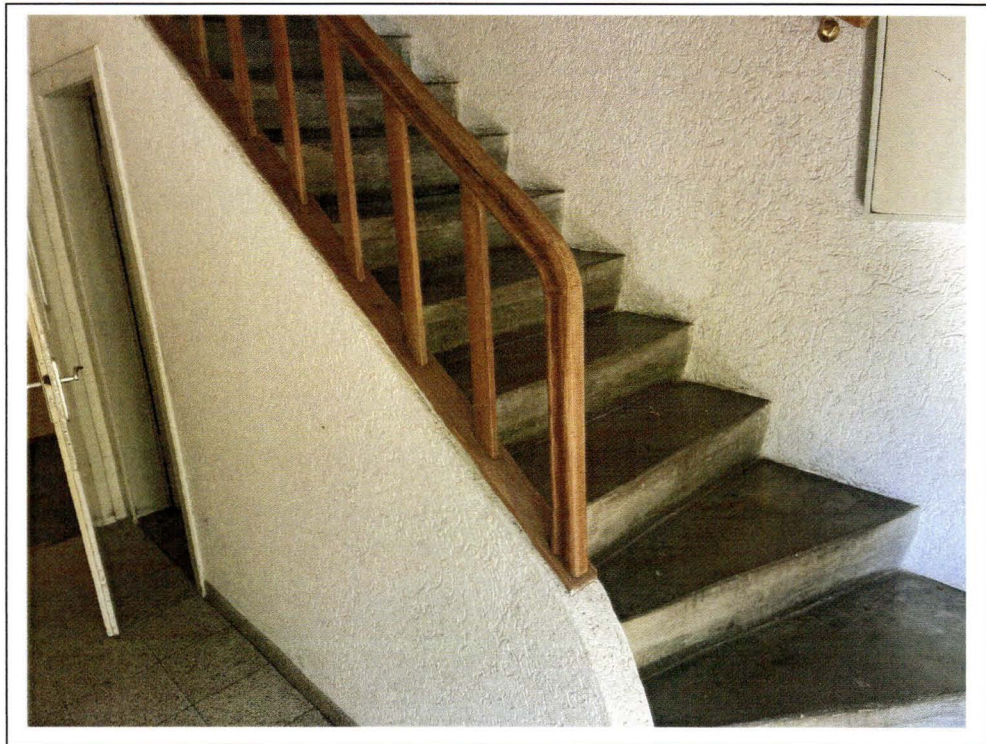
Foto 11: Treppe zum Dachgeschoss
