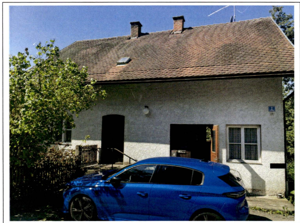
Foto 4: Ansicht von Osten
