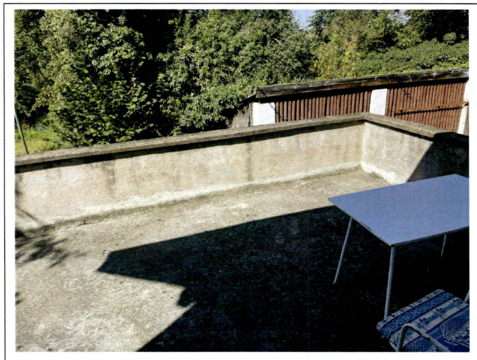
Foto 18: Blick auf die EG-Dachterrasse
