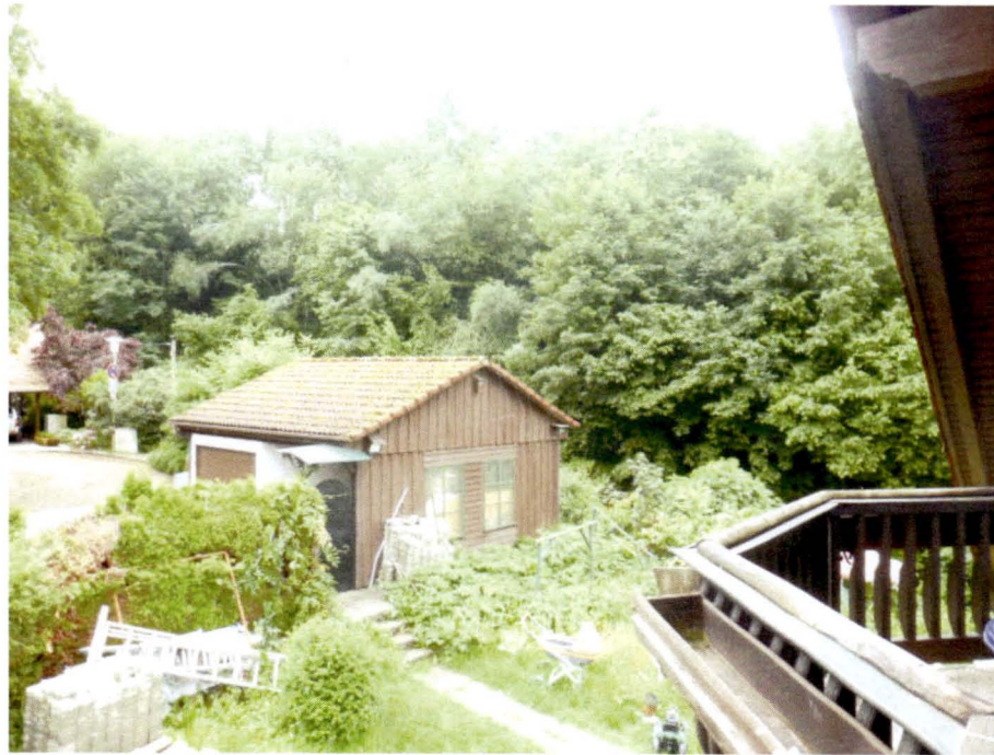
Blick von Norden (vom Balkon des Zweifamilienhauses) auf das Nebengebäude
