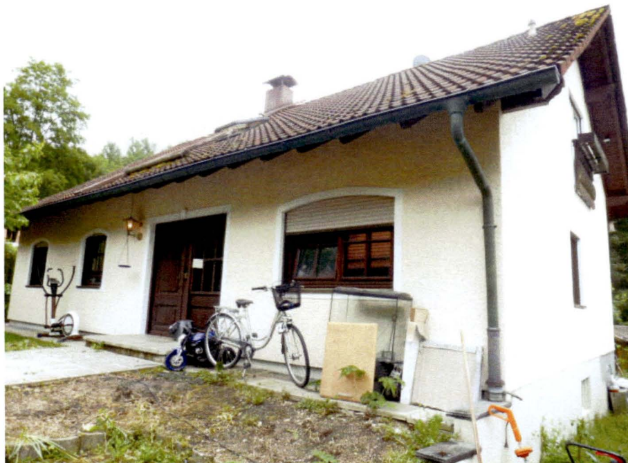
Blick von Norden auf das Wohngebäude
