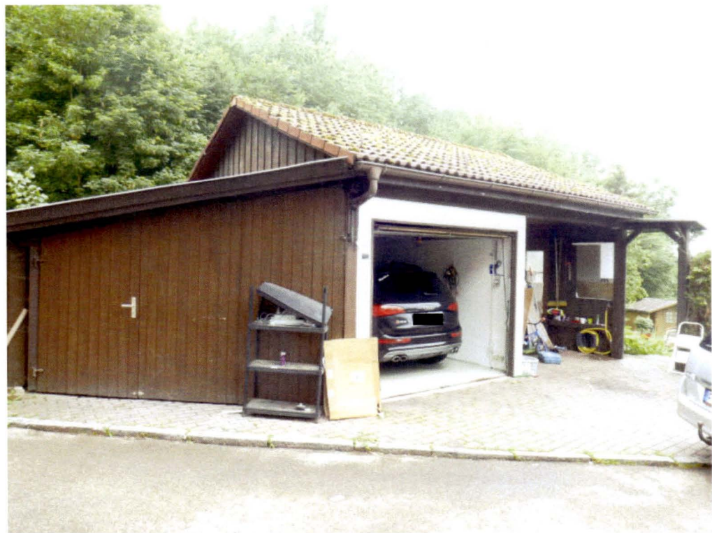
Blick von Osten auf das Nebengebäude
