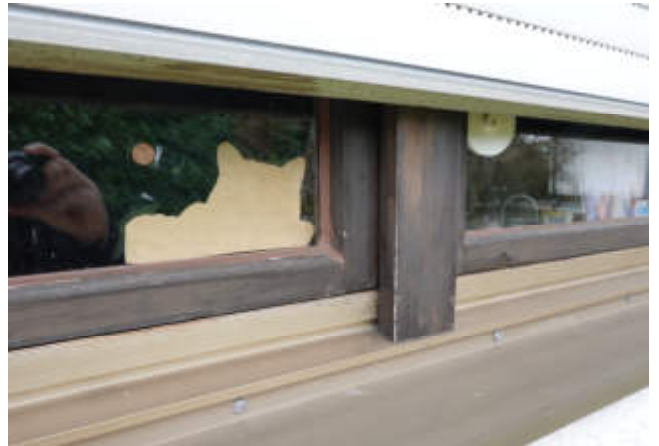
Angewitterte Holzbauteile
