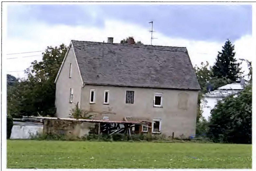
Foto 4: 89346 Silheim, Ortsstraße 12, Ansicht Nord
