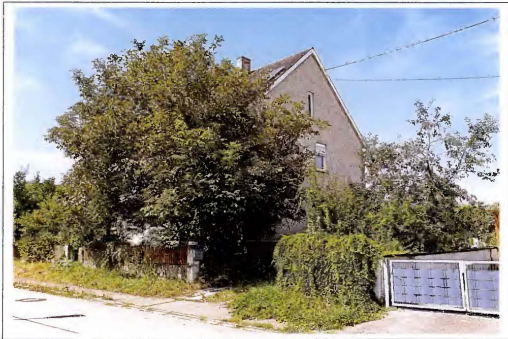
Foto 3: 89346 Silheim, Ortsstraße 12, Ansicht Südost
