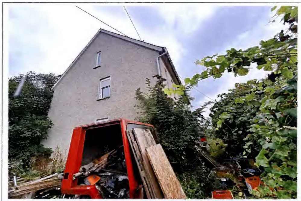
Foto 2: 89346 Silheim, Ortsstraße 12, Ansicht Südwest
